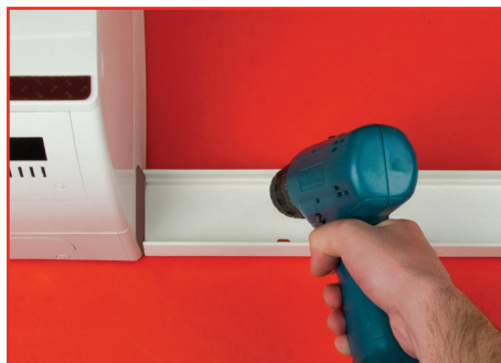
Закрепите основание короба на стене
